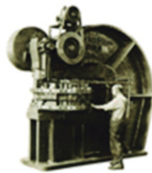
图 11 电动式转塔压力机
